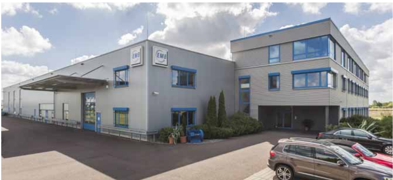
Figura 1 - Edificio de la empresa EMB
